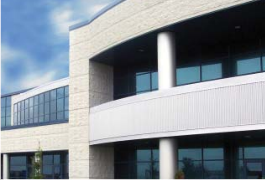
La Maison de l'industrie de Drummondville où le Centre universitaire PME a élu domicile.
